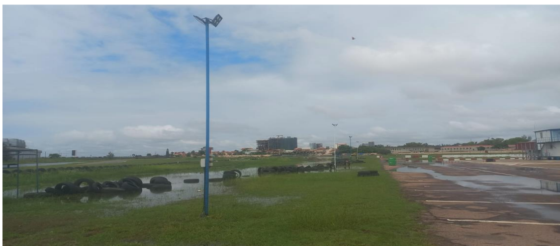
Novo poste de iluminação
