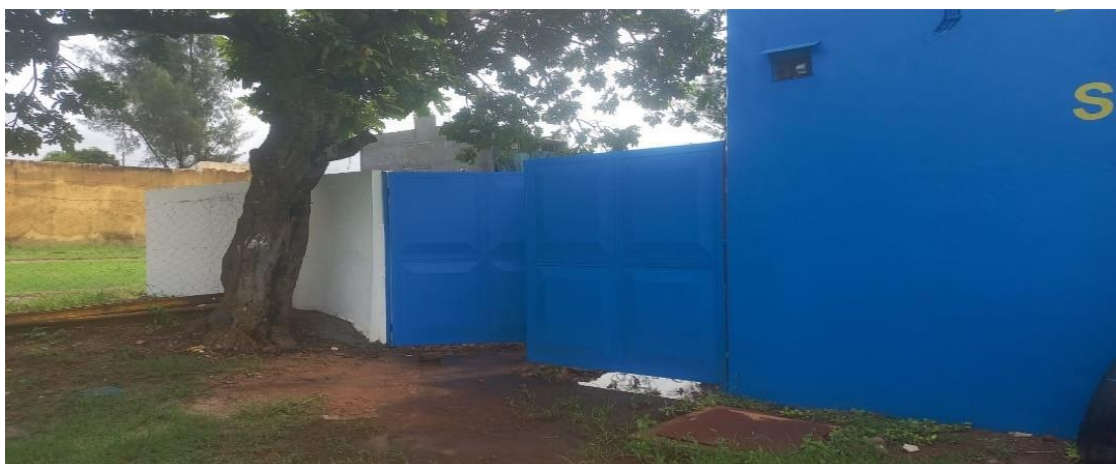
Novos portões de serviço nas bancadas
