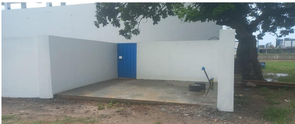
Espaço para receber o gerador externo na zona das bancadas
