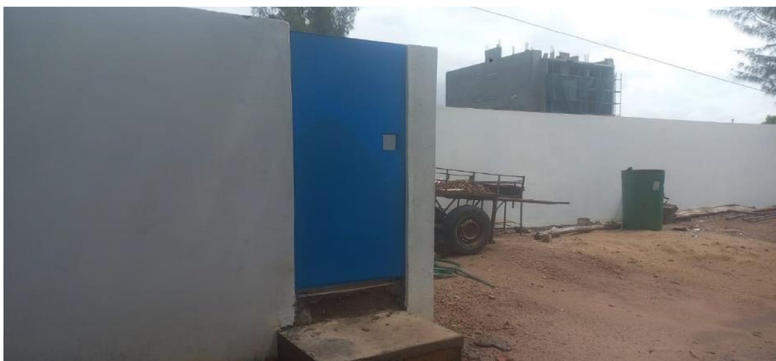
Muro novo na zona de serviço das bancadas
